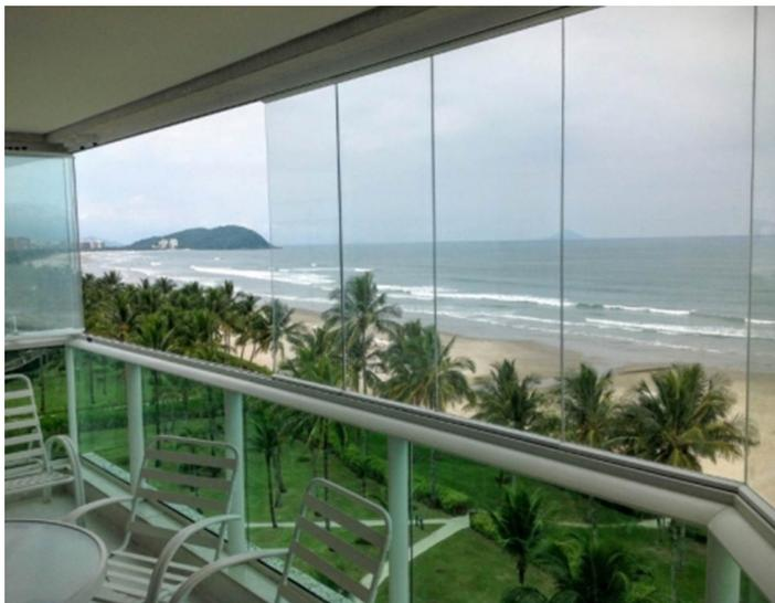
**Versatilidade:** O sistema de envidraçamento se adapta a estruturas de medida de vãos de até 2000mm de altura e vidros de até 600 mm de largura.
